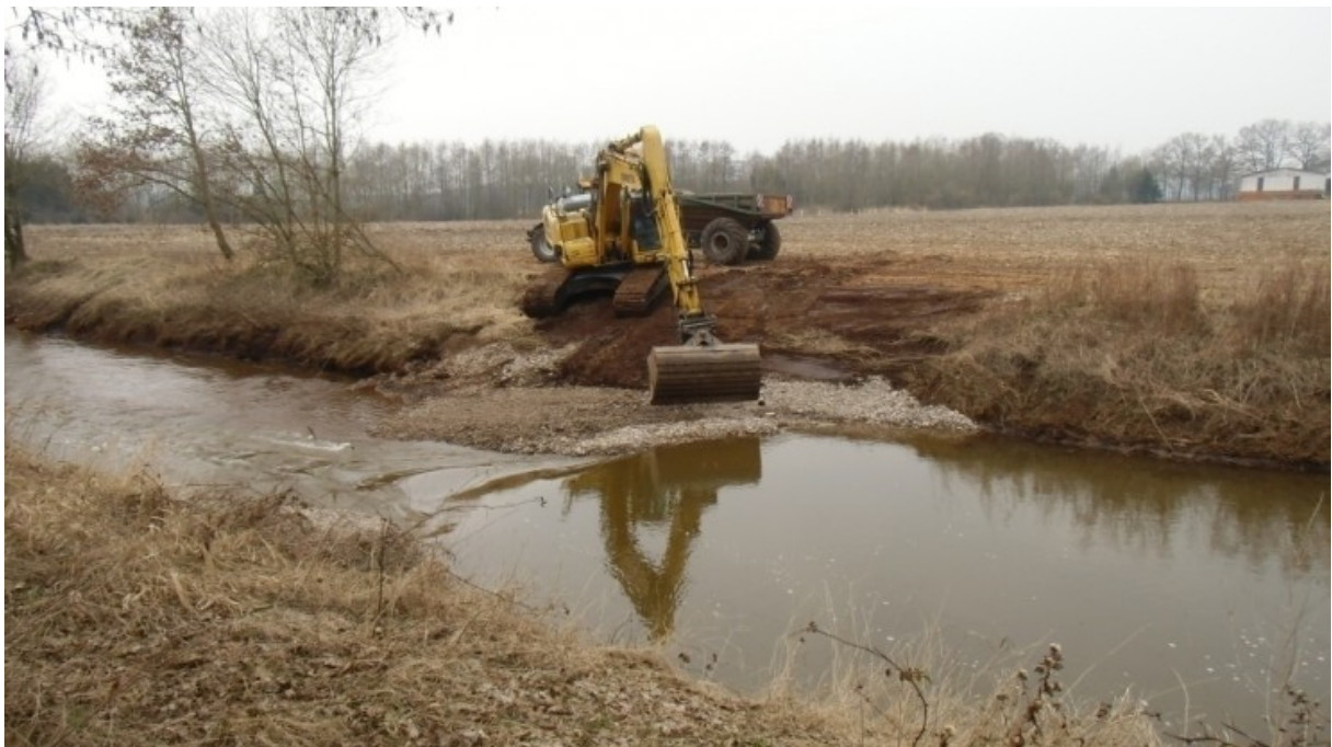
Abbildung 16: Einbringung von Kies für die Schaffung von Laichplätzen - Mittelradde (Deutschland)
