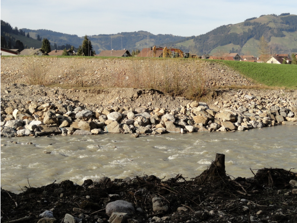
Abbildung 3: Röhrenverbauung im Bereich des Ablenkdammes Minster
