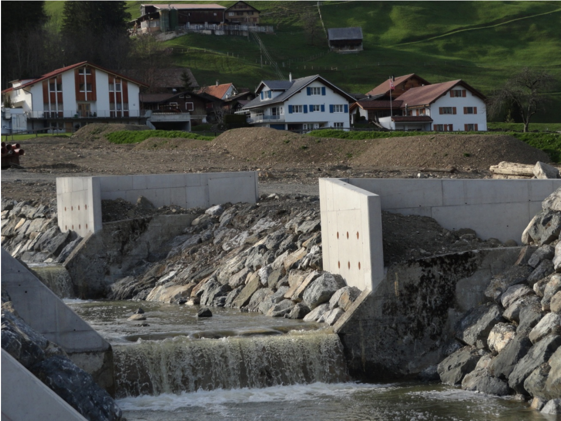
Abbildung 7: Gewässerverbauungen im Bereich Nidlaubach (1/2)
