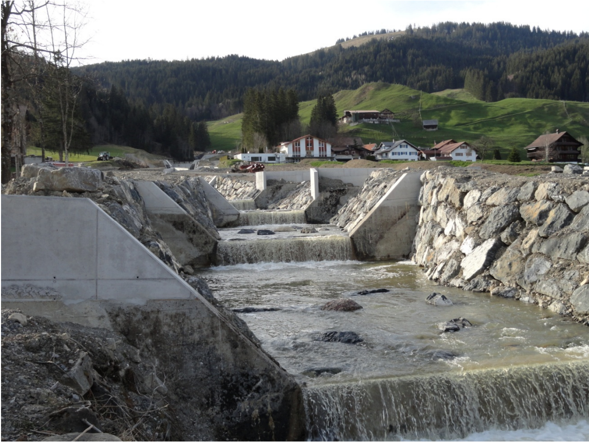
Abbildung 6: Gewässerverbauungen im Bereich Nidlaubach (1/2)
