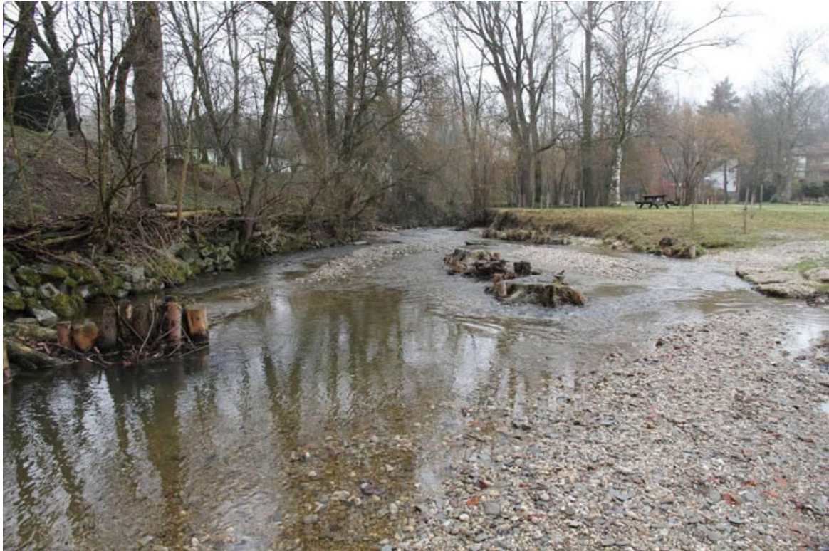
Abbildung 10: Einbringung von Totholz für Fischunterstände - Breitsach (Österreich)
