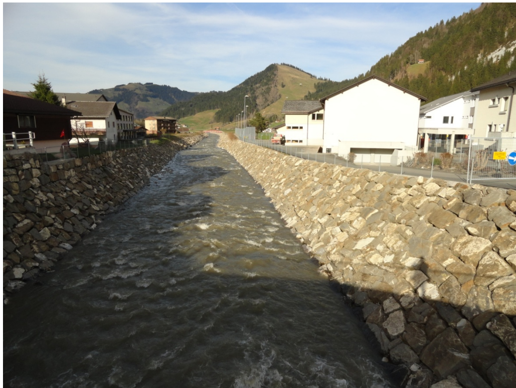
Abbildung 1: Hochwasserschutz Minster (Los 1)
