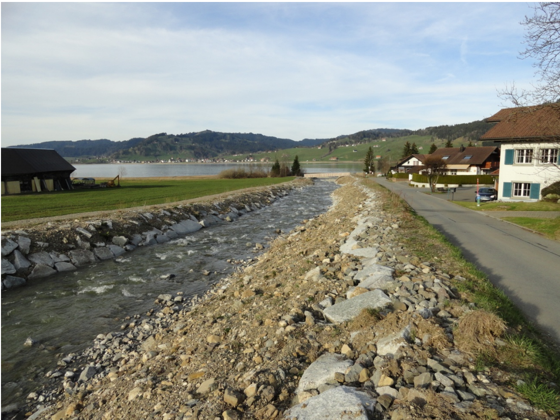
Abbildung 9: Hochwasserschutz Grossbach im Bereich Einmündung Sihlsee
