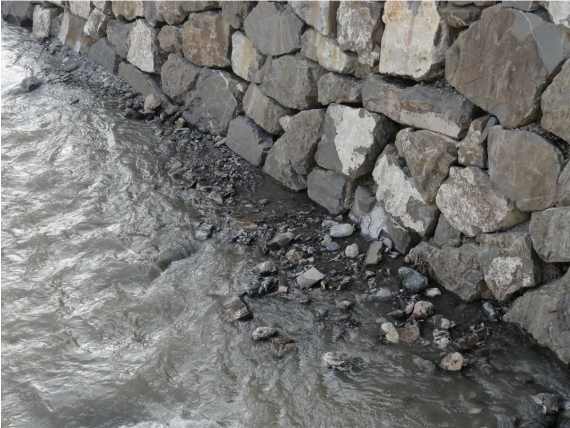
Abbildung 2: Gerinneverbreiterung und Abflachung der Ufer im Bereich Dorfbrücke Minster
