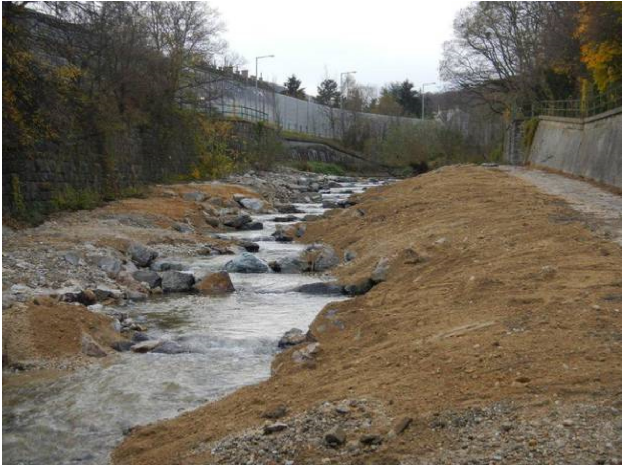
Abbildung 15: Aufgelöste Sohlrame - Wienfluss (Österreich)
