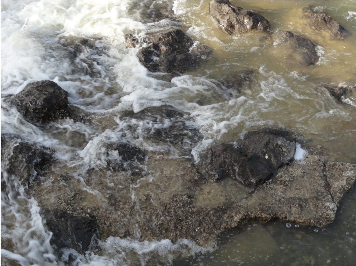
Abbildung 8: Harter Sohlenverbau bei der Verbauung Nidlaubach
